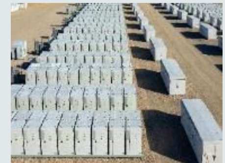
Batterie- und Wärmespeicher
